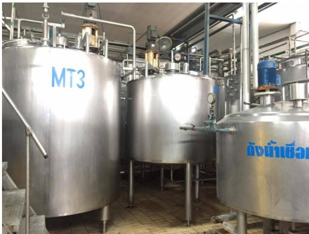
รูปที่ 1 ถังหมักนม (2 ถัง) ถังผสม (2 ถัง) และถังน้ำเชื่อม (1 ถัง) อุปกรณ์สำหรับผลิตนมเปรี้ยวของ
